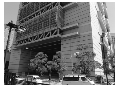
大阪府立国際会議場
